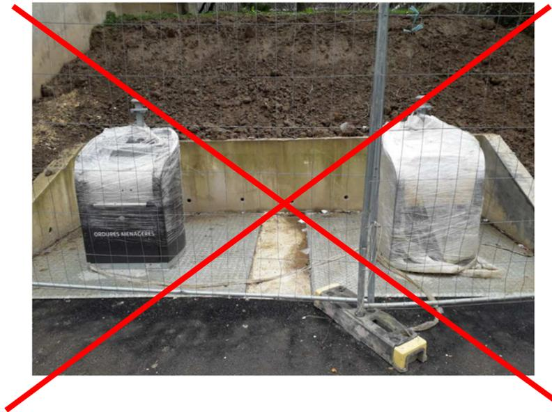
De même, il conviendra d'aménager les bornes de sorte d'éviter les infiltrations d'eau à l'intérieur des cuves (joint autour des plateformes, denivelé, etc.).
