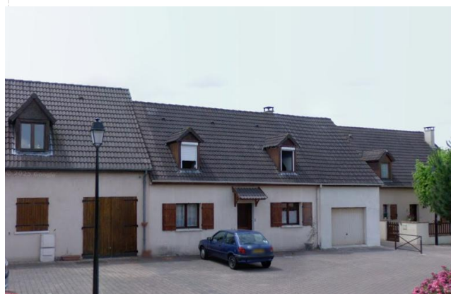
Quartiers résidentiels construits dans les années 1980-1990
