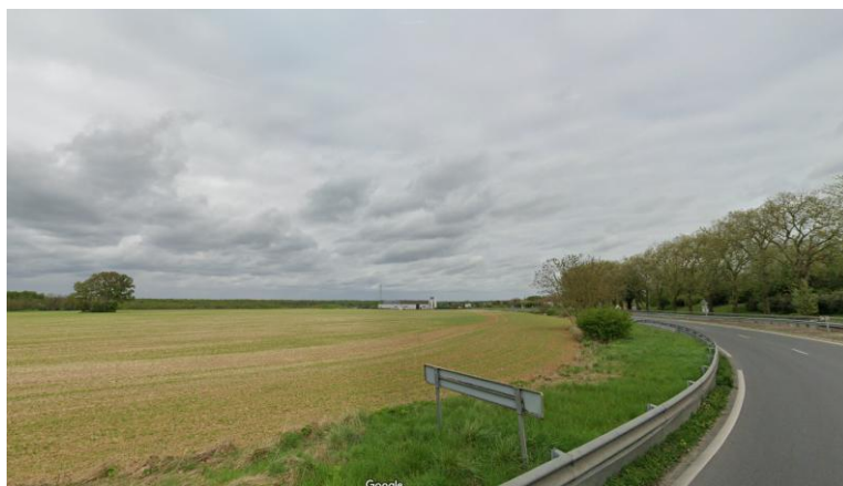
Figure 14 : Secteur de projet, vue depuis la RD33
